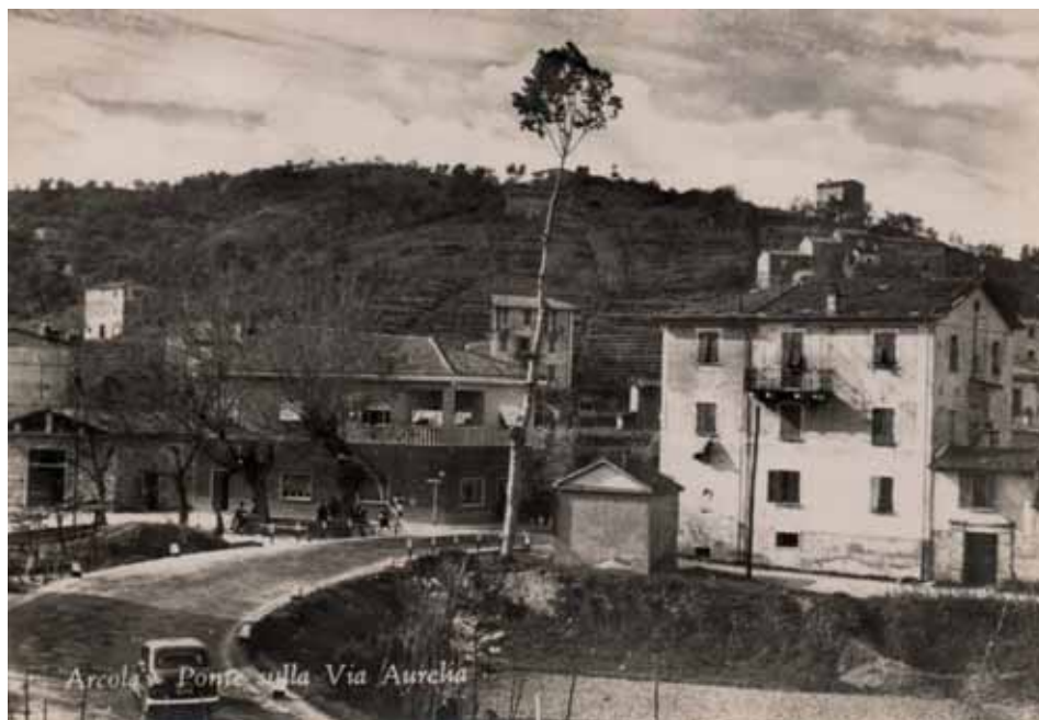
- Arcola - Ponte sulla Via Aurelia
